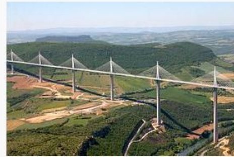
Viaduc de Millau
